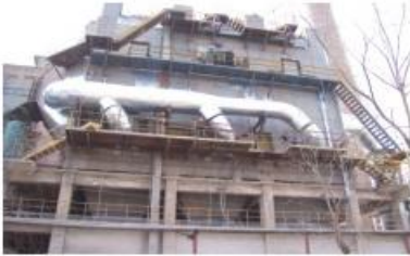
北京新港水泥厂
